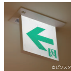
非常口や避難口までの通路や経路を表す避難経路誘導灯
