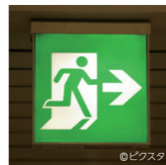
非常口、避難口そのものの場所を表す避難口誘導灯
